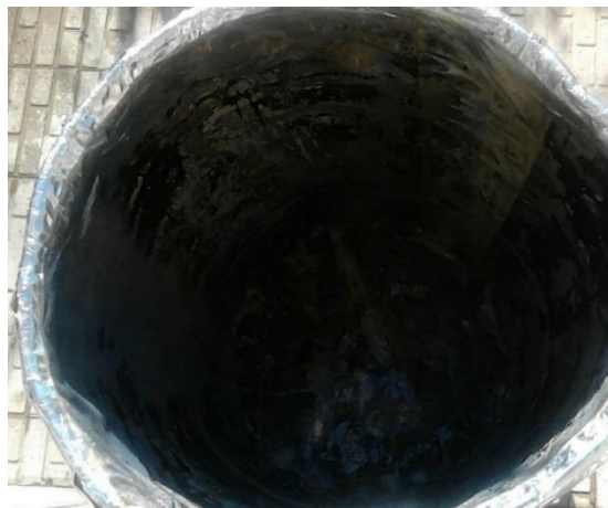
شکل ۲- رنگ آمیزی و عایق بندی جداره داخلی استخر
